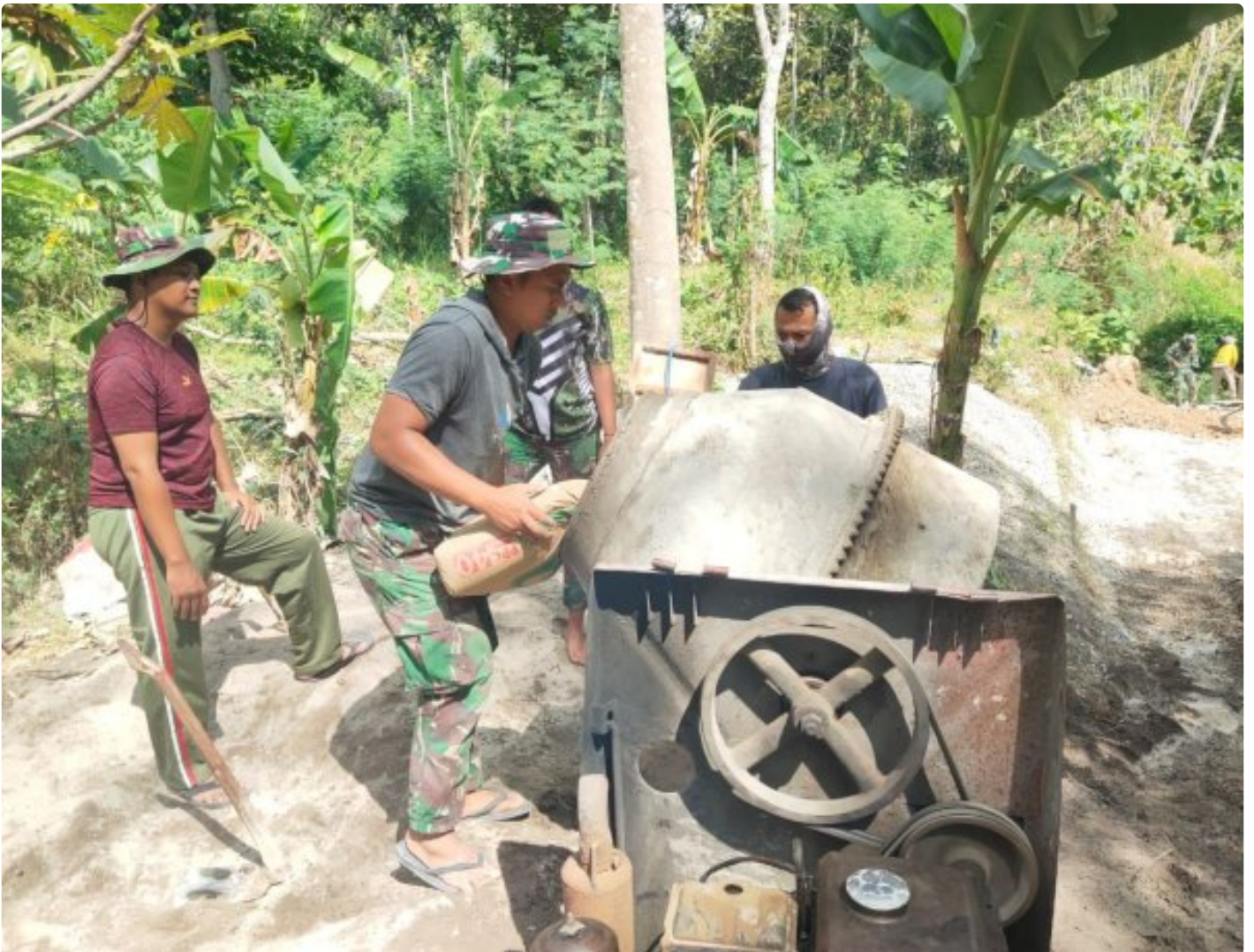
Foto: Mesin Molen, Senjata Utama Satgas Pembuatan Jalan Dalam Program TMMD ke-121 di Kodim Rembang.
